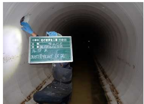
管口仕上状況
